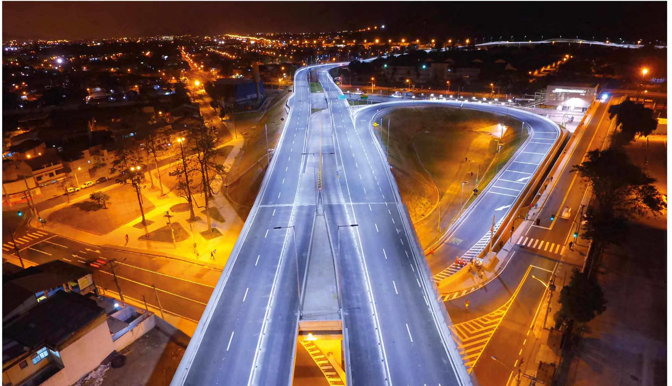
Luminaria vial **SIMON NATH** con tecnología Istanium LED proporciona la iluminación necesaria en alumbrado vial con la máxima eficiencia. La óptica Vial frontal es de tipo RJ al estar las luminarias ubicadas en la mediana
